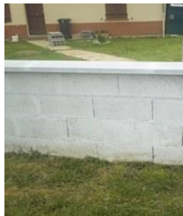
MUR DE CLOTURE NON ENDUIT
